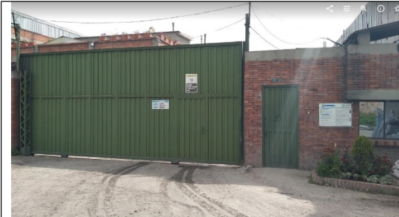
FOTO No. 1 FACHADA DEL PREDIO.
